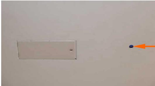
Der Rückstellstift des mechanischen Übertemperaturschutzes befindet sich an der Unterseite des Heizeinschubes. Drücken Sie den Rückstellstift z. B. mit einem Kugelschreiber wieder ein (ca. 1mm).
